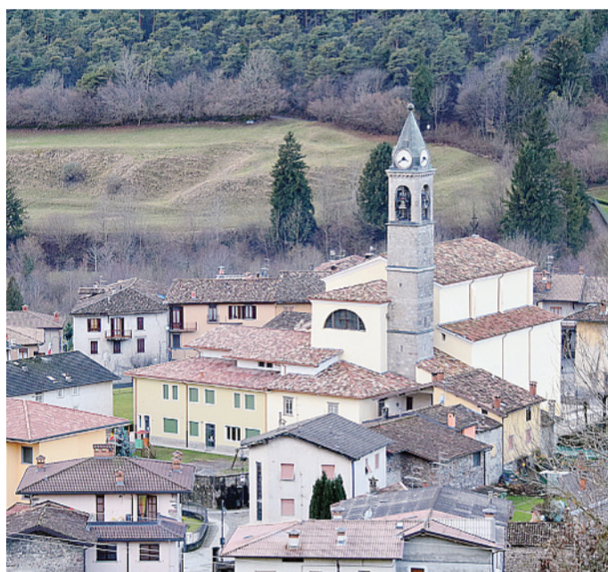
Restauri a tetto e facciata per la chiesa parrocchiale di Cerete Basso
